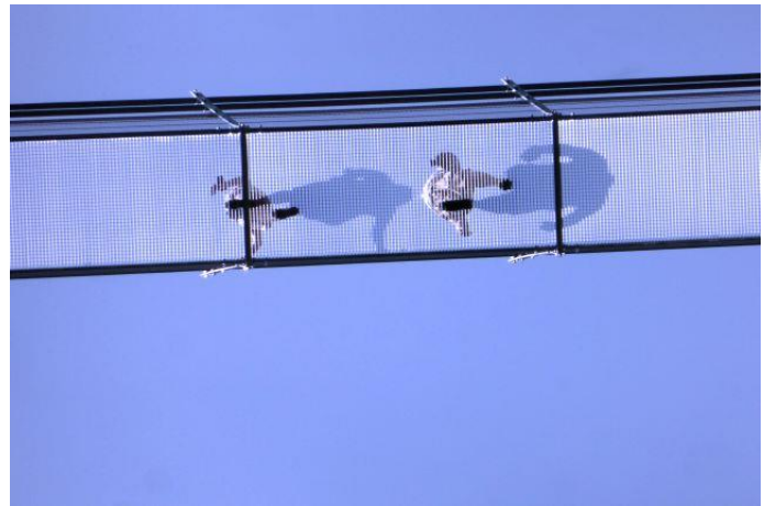
Fußgänger-Hängebrücke (Ehrenberg); Foto: Ingrid Penner
